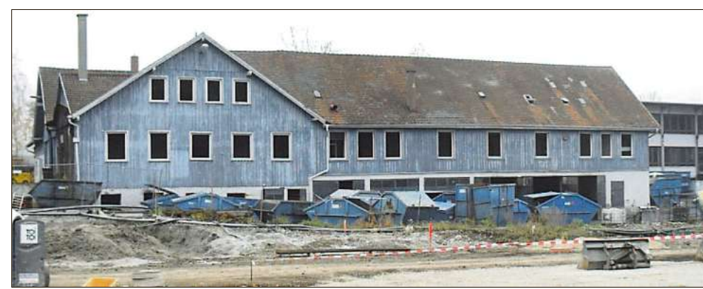
Abbruch der alten Halle in Deißlingen im Jahr 2011
